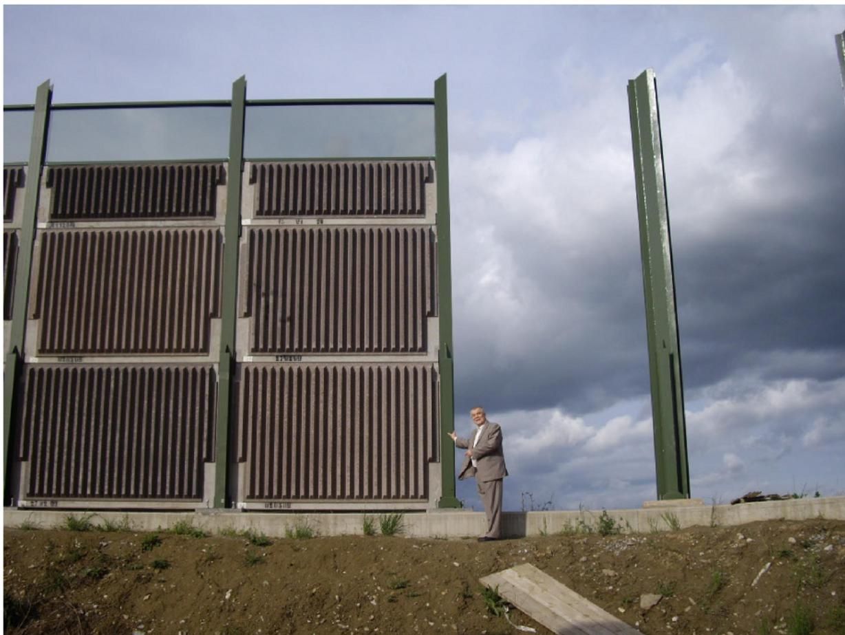
Рисунок 2.5 - Бетонный шумозащитный экран
