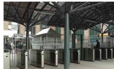
Турникетная линейка на Ленинградском вокзале в г. Москве
